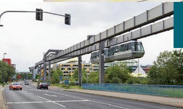
Réalisation de trams ferroviaires et aériens s'appuyant sur des poteaux suspendus
